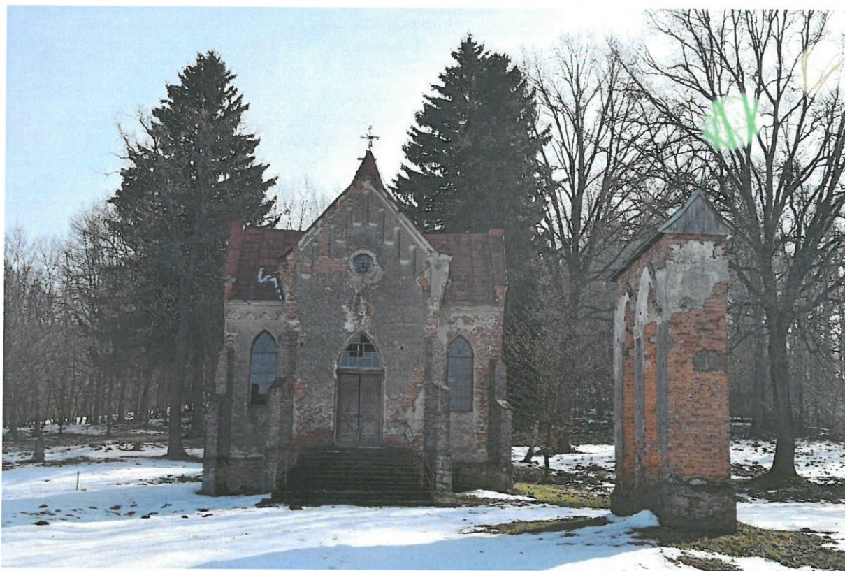
Fot. 7. Wołódź. Kaplica wraz z dzwonnica (fot. autor opracowania).
