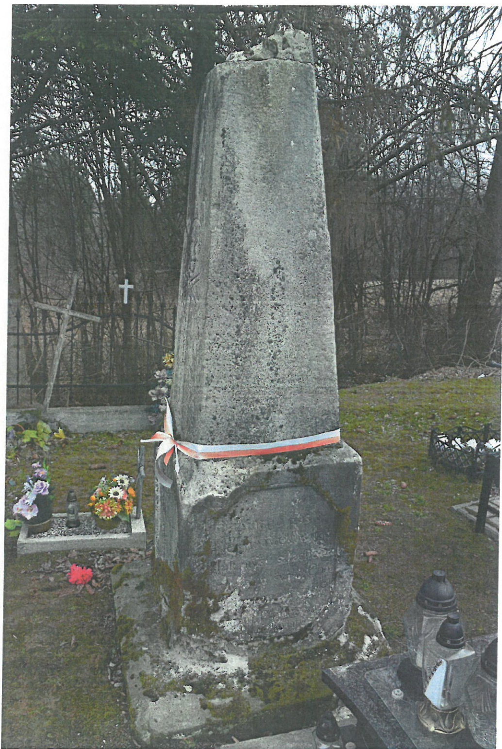
Fot. nr 3. Pomnik „Grób Pańszczyzny”. Widoczne na fotografii; zabrudzenia na powierzchni, uszkodzenia mechaniczne, ubytki kamienia, mchy, porosty pokrywające powierzchnię kamienia. Fot. Mariusz Wrona marzec 2022 r.
