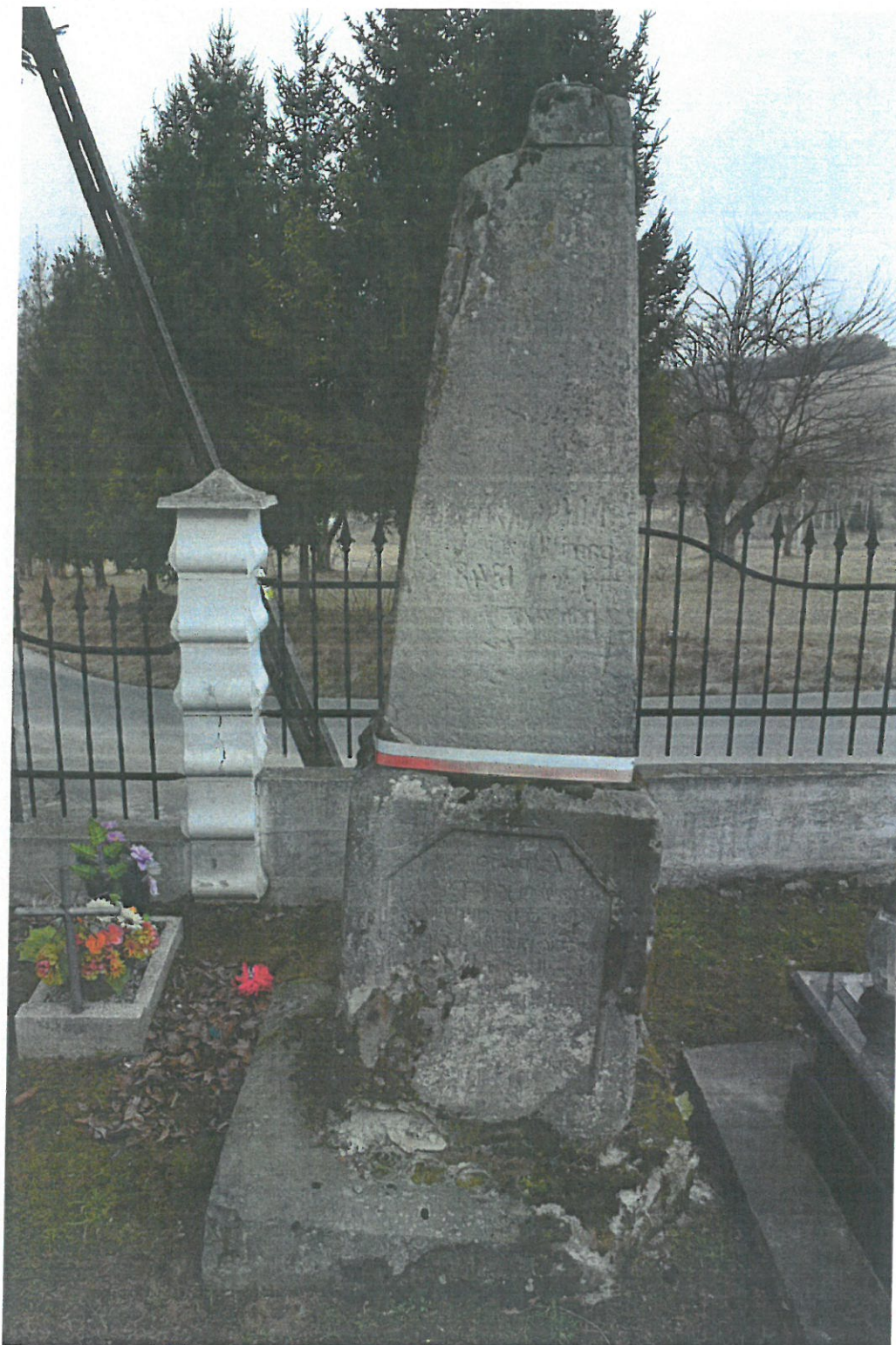
Fot. nr 1. Pomnik „Grób Pańszczyzny”. Widoczne na fotografii; zabrudzenia na powierzchni, uszkodzenia mechaniczne, ubytki kamienia, mchy, porosty pokrywające powierzchnię kamienia. Fot. Mariusz Wrona marzec 2022 r.
