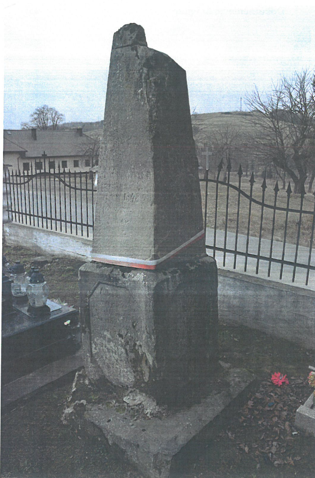
Fot. nr 2. Pomnik „Grób Pańszczyzny”. Widoczne na fotografii zabrudzenia powierzchni, uszkodzenia mechaniczne, ubytki kamienia, mchy, porosty pokrywające powierzchnię kamienia. Fot. Mariusz Wrona marzec 2022 r.
