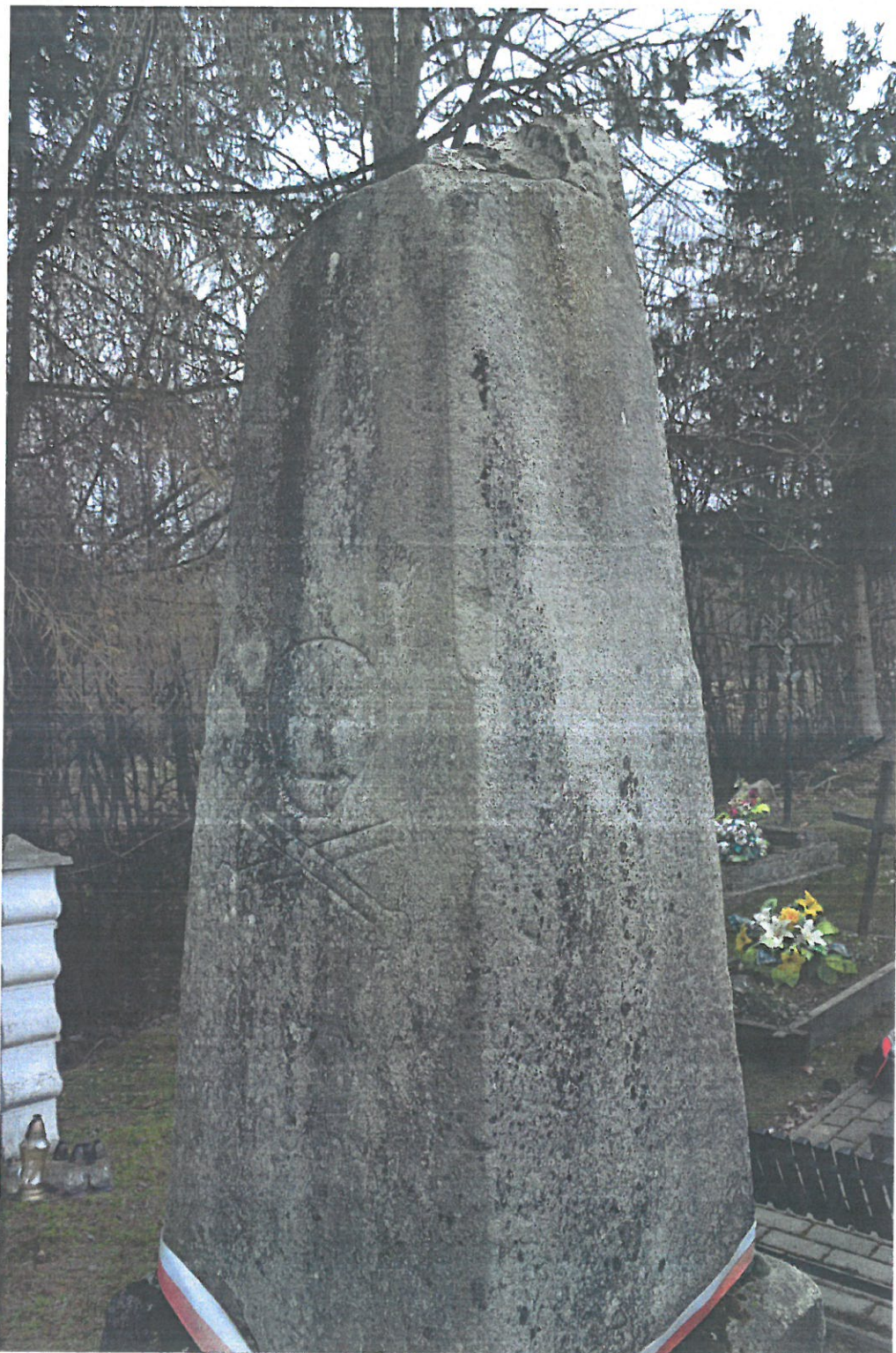
Fot. nr 4. Pomnik „Grób Pańszczyzny”. Widoczne na fotografii; znaczący ubytek w obrębie zwieńczenia pomnika, liczne zabrudzenia powierzchni kamienia, zaoblona forma rzeźbiarska. Fot. Mariusz Wrona marzec 2022 r.
