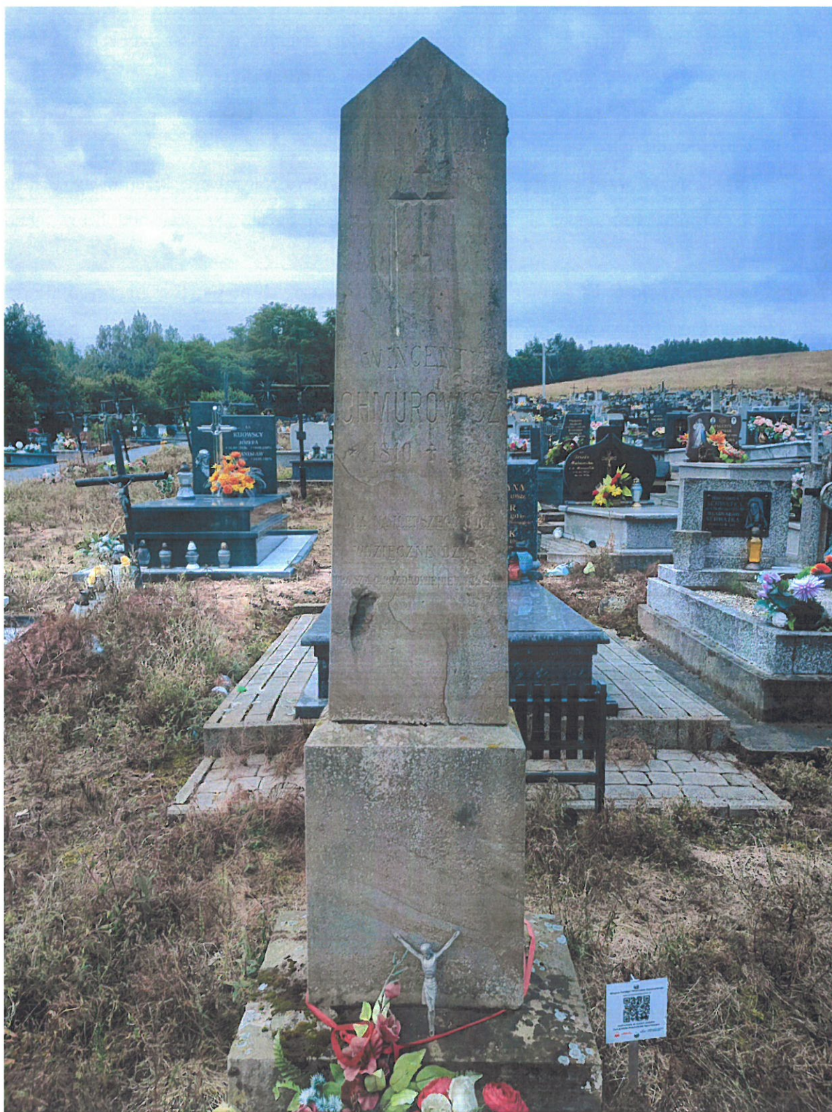
Fot. nr 1. Nagrobek Wincentego Chmurowicza z cmentarza parafialnego w Nozdrzcu. Widoczne na fotografii, silne zabrudzenie powierzchni kamienia, mchy, porosty oraz inne mikroorganizmy pokrywające powierzchnię kamienia,
