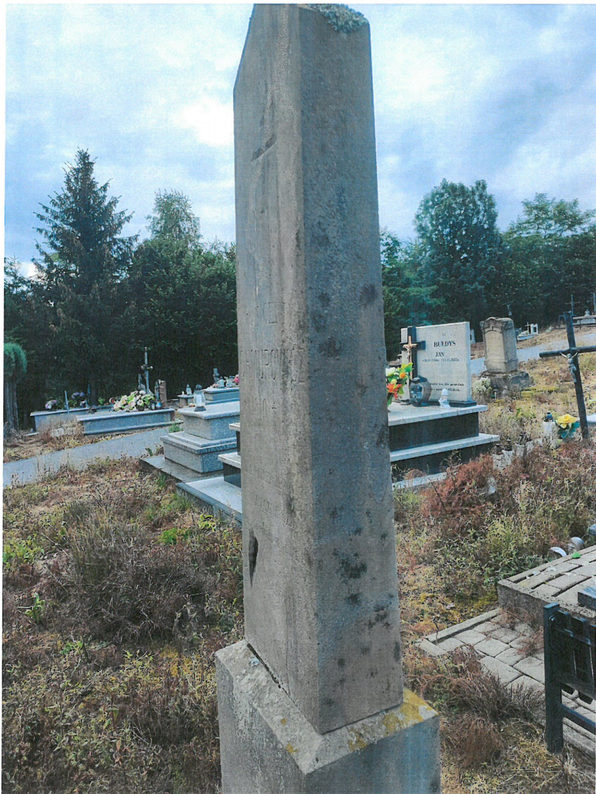
Fot. nr 2. Nagrobek Wincentego Chmurowicza z cmentarza parafialnego w Nozdrzcu. Widoczne na fotografii, silne zabrudzenie powierzchni kamienia, mchy, porosty oraz inne mikroorganizmy pokrywające powierzchnię kamienia,
