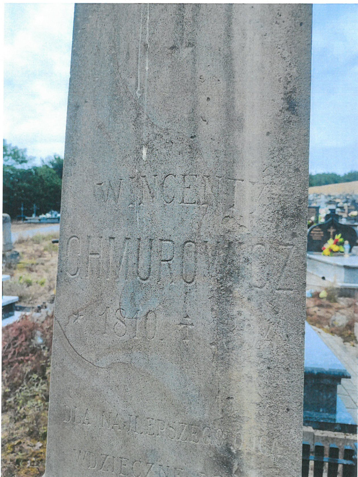
Fot. nr 4. Nagrobek Wincentego Chmurowicza z cmentarza parafialnego w Nozdrzcu. Widoczne na fotografii, korozja powierzchniowa kamienia, ubytki kamienia doprowadzające do ograniczonej czytelności inskrypcji. Fot. Tomasz Chryń
