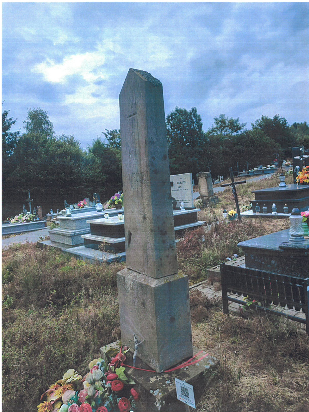
Fot. nr 3. Nagrobek Wincentego Chmurowicza z cmentarza parafialnego w Nozdrzcu. Widoczne na fotografii, silne zabrudzenie powierzchni kamienia, mchy, porosty oraz inne mikroorganizmy pokrywające powierzchnię kamienia,
