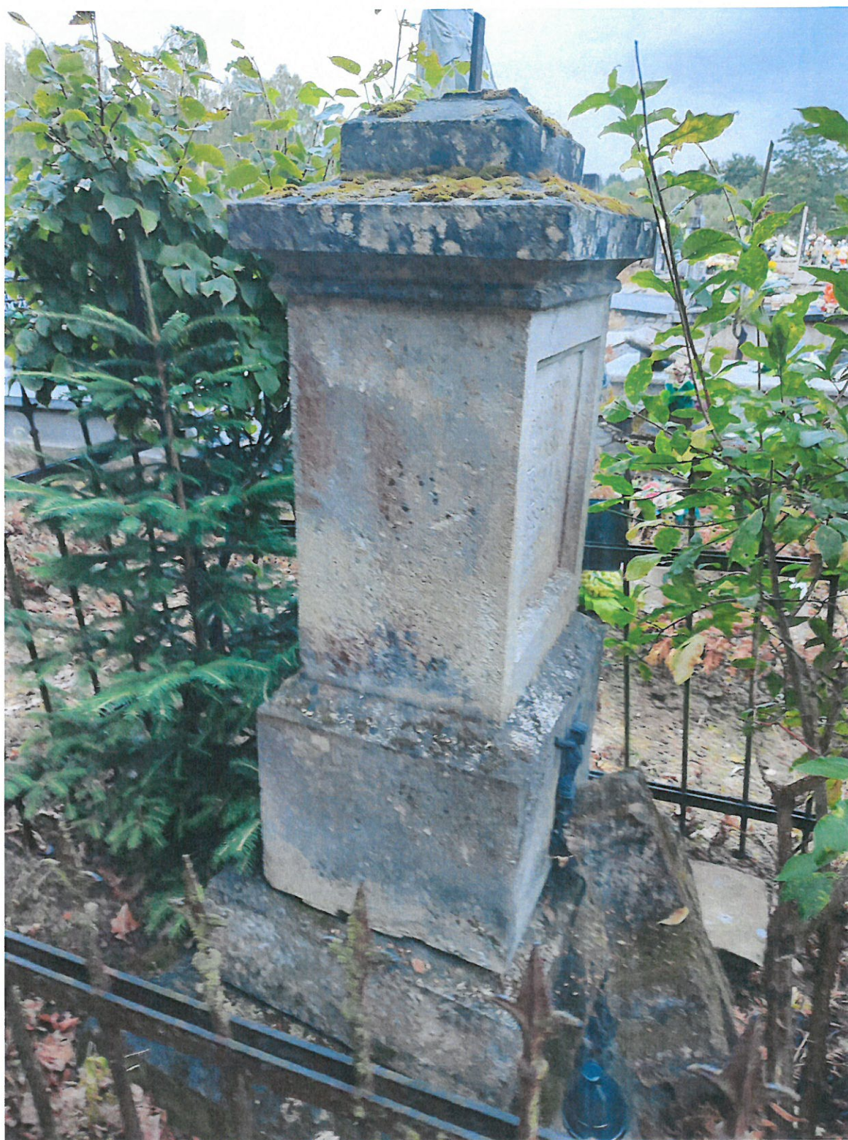
Fot. nr 3. Nagrobek Wiktorii Gierula z cmentarza parafialnego w Nozdrzcu. Widoczne na fotografii, silne zabrudzenie powierzchni kamienia, mchy, porosty oraz inne mikroorganizmy pokrywające powierzchnię kamienia, głęboko strukturalne zaplamienia.
