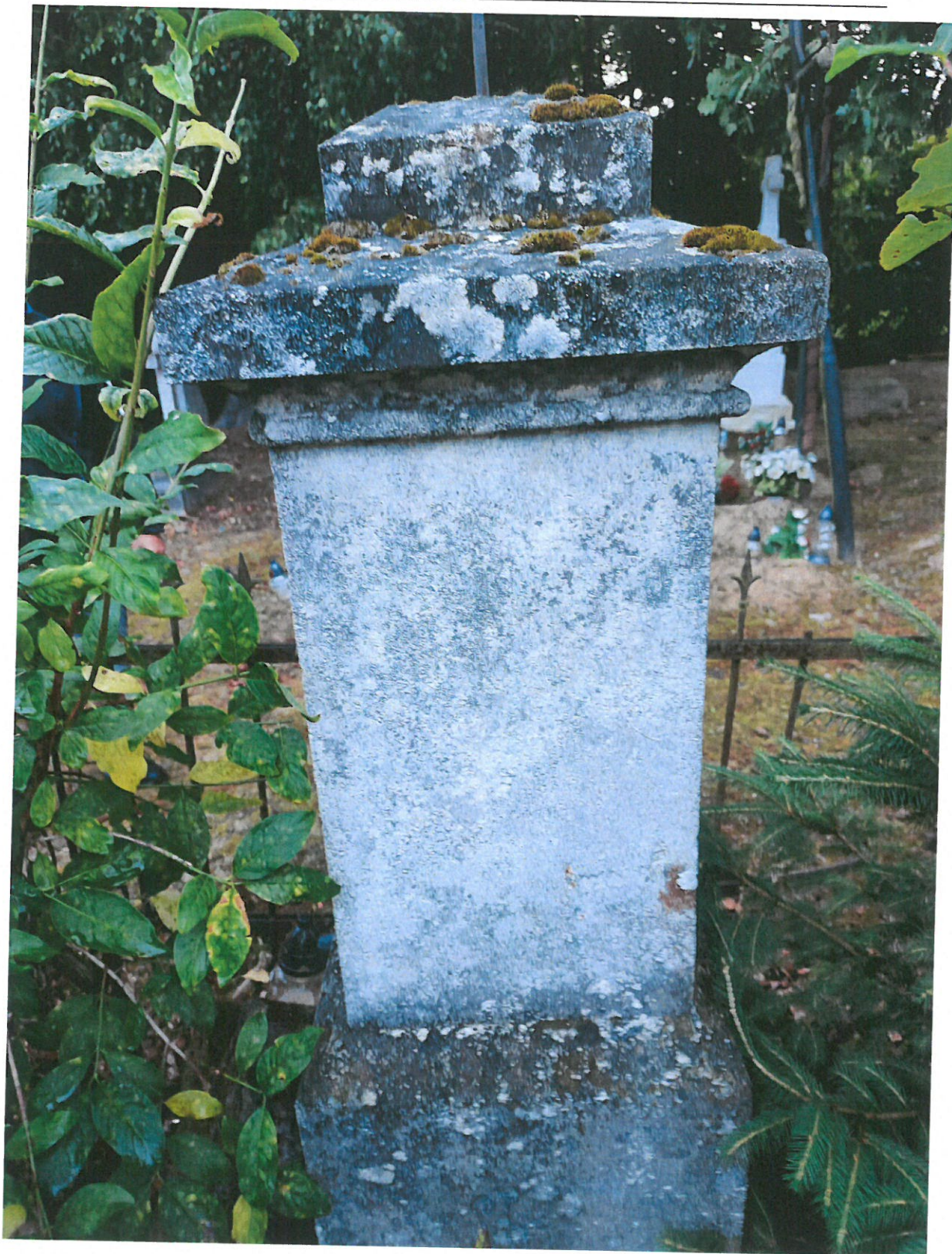
Fot. nr 4. Nagrobek Wiktorii Gierula z cmentarza parafialnego w Nozdrzcu. Widoczne na fotografii, silne zabrudzenie powierzchni kamienia, mchy, porosty oraz inne mikroorganizmy pokrywające powierzchnię kamienia, głęboko strukturalne zaplamienia..
